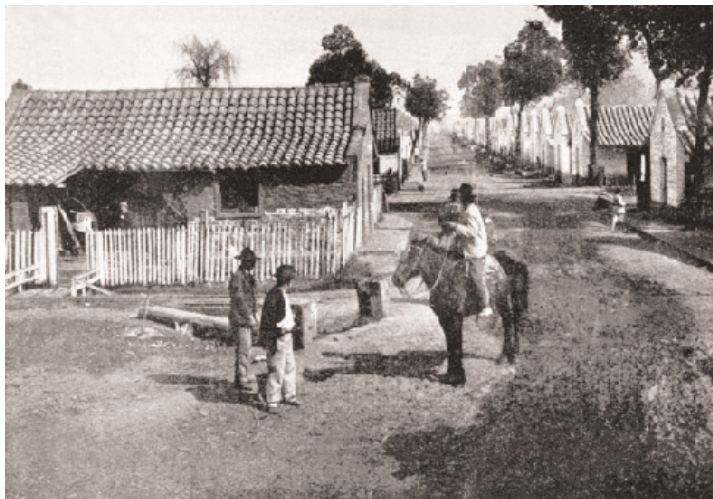
Barrio obrero (Ingenio "Santa Ana", Tucumán)
